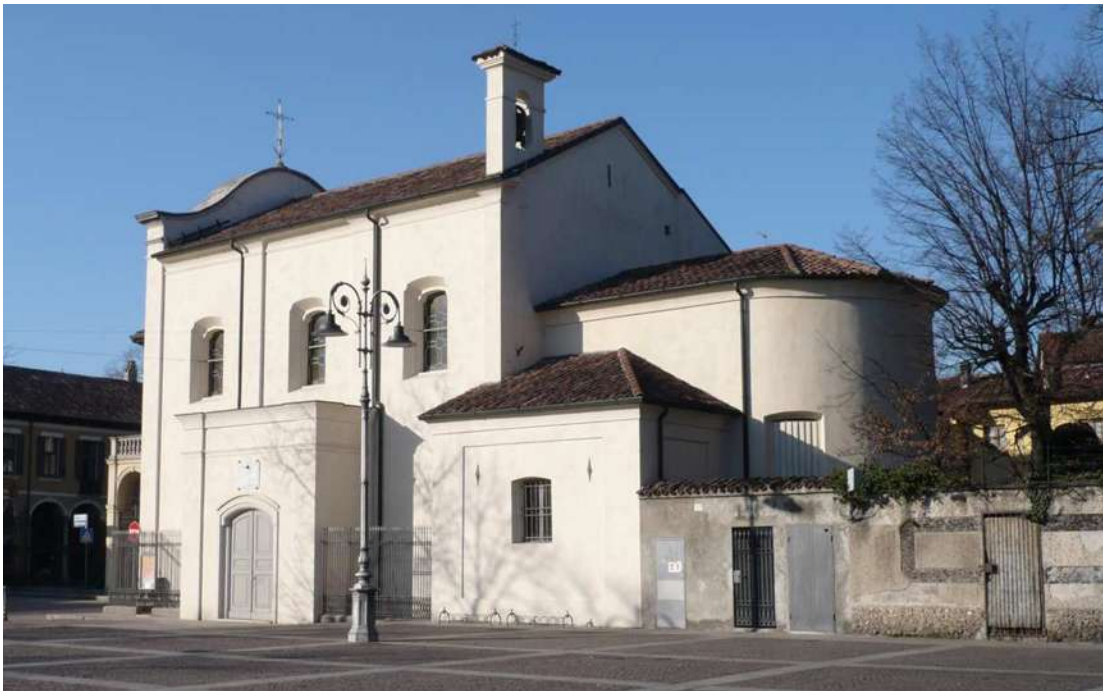
Fig. 40. Inzago 2010 - San Rocco con il nuovo ingresso laterale
